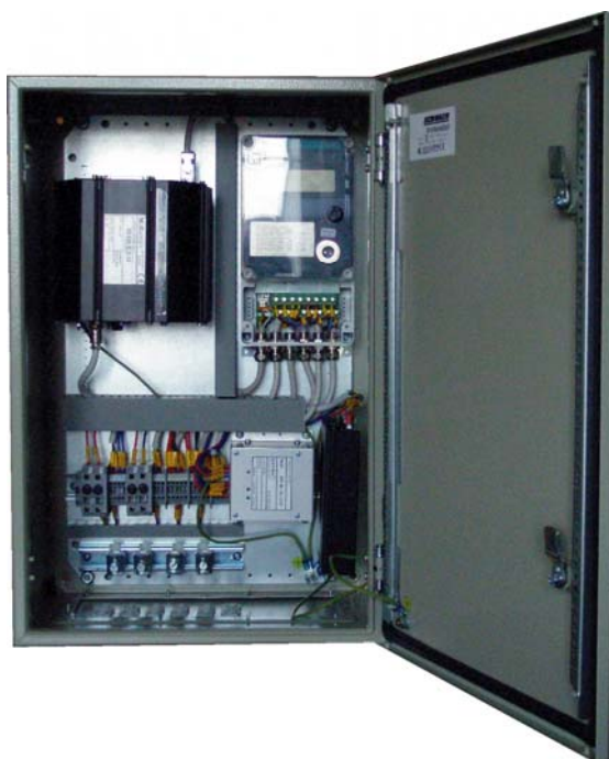
Obr.2 Skříň WATTMET - Centrální část systému měření
