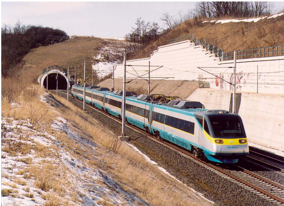
Obr. č. 1 – Jednotka 680.003 ve zkušebním provozu projíždí na spoji R 772 Praha Masarykovo nádraží – Děčín přeložku trati u nového Vepřeckého tunelu (leden 2005)
